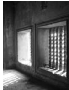
Fig.25. Barandilla de piedra en una ventana (Angkor Wat) (Foto: Jose M. Cabeza)
