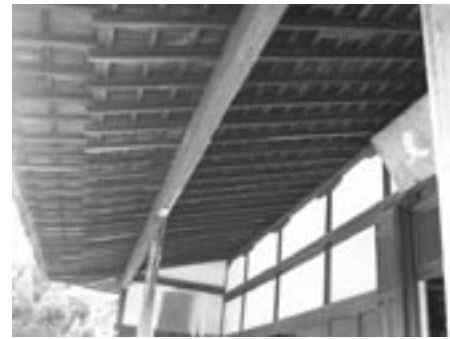
Fig. 20. Los aleros orientados al sur del templo en Ryōanji con vigas de color claro de madera.
